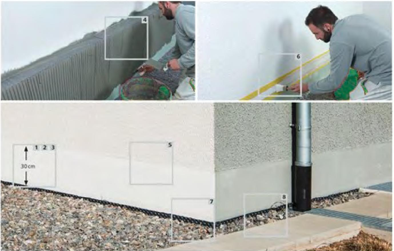
Pour protéger l'isolation du socle, il est recommandé d'installer un film à bulles recouvert de non-tissé. Une bande anti-éclaboussures/anti-pluie de 30 cm de large avec drainage protège le sous-bassement des salissures et d'une pression d'eau accrue..
